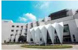
Завод в г. Тайнань
