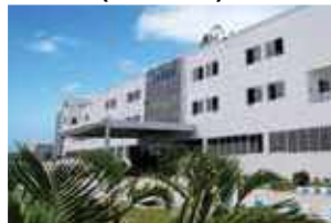
Завод в г. Рудрапур
